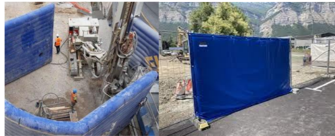
Figure 80 : Mesures de réduction envisageables : matelas acoustique ou bâche
