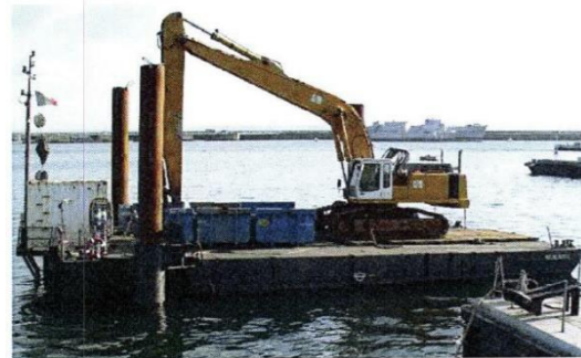
Figure 23 : Extraction des sédiments : une pelle télescopique positionnée sur un ponton flottant
