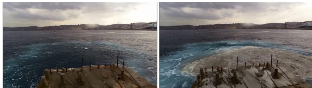
Figure 51 : Exemple d'efficacité d'un rideau de bulle, avant et après tir de minage (source : EPC-OCCAMAT)
