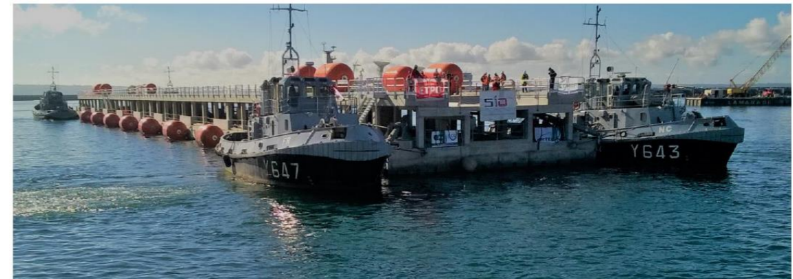
Figure 25 : Amenée du ponton par flottaison
