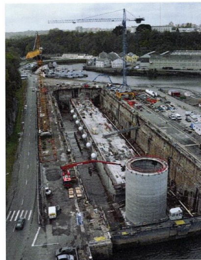
Figure 22 : Construction du ponton et du musoir en forme de radoub, avant mise en eau
